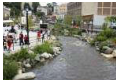
Рисунок 4 - Набережная после реконструкции
