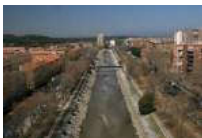
Рисунок 5 - Набережная до реконструкции
