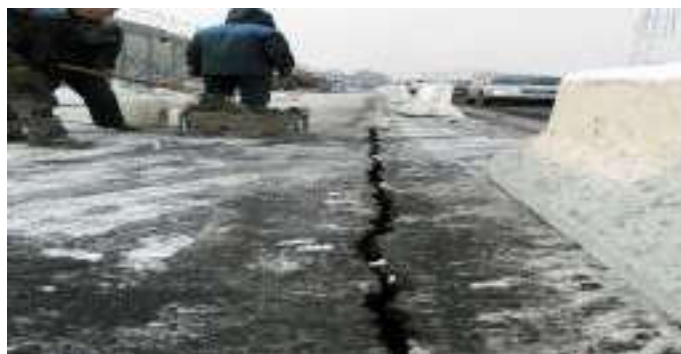
Рисунок 2 - Трещина от усадки подземного комплекса «Алмалы».[6]
