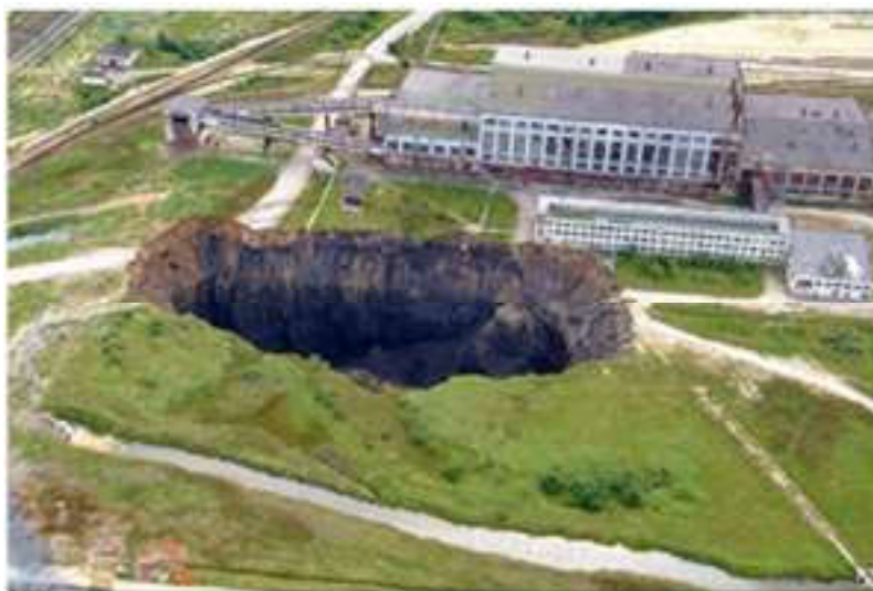
Рисунок 1 - Провал грунта на территории завода «Уралкалий»
