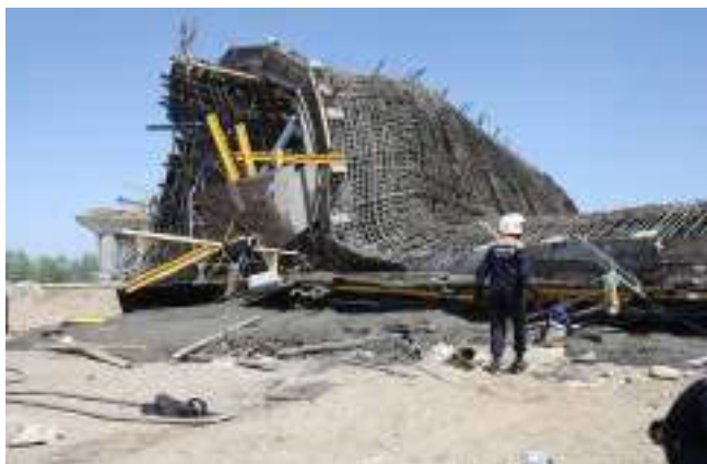
Рисунок 3 - Обрушение моста в г.Алматы.[5]
