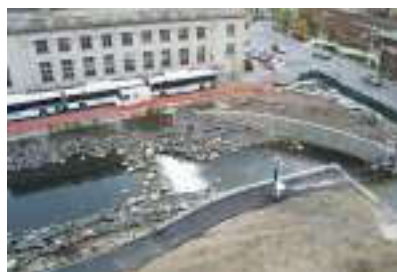
Рисунок 3 - Набережная реки Соумил во время реконструкции
